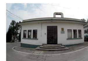
Modificación del laboratorio Se convierte en Laboratorio de Alta Seguridad Nivel 3
