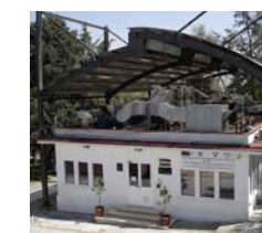
Modernización del LBS3 Se inicia la modernización culminando en 2006
