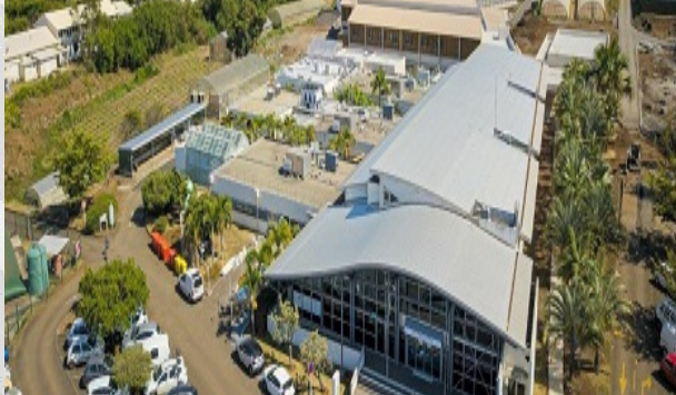
Edificio Polo Fitosanitario de Saint Pierre: Fuente: Cirad
